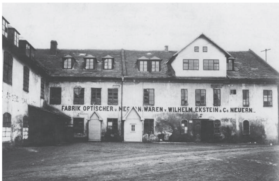
Budova továrny kolem roku 1920
