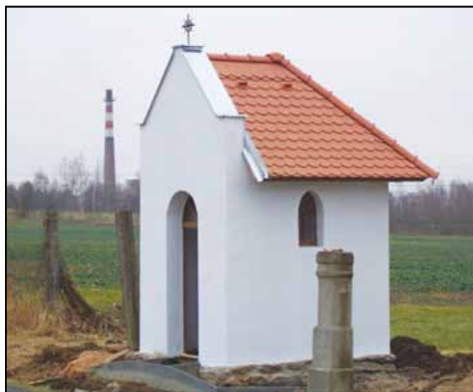
Opravená kaplička při silnici na Hodousice.
