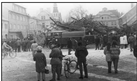
Trosky kostela po demolici.
