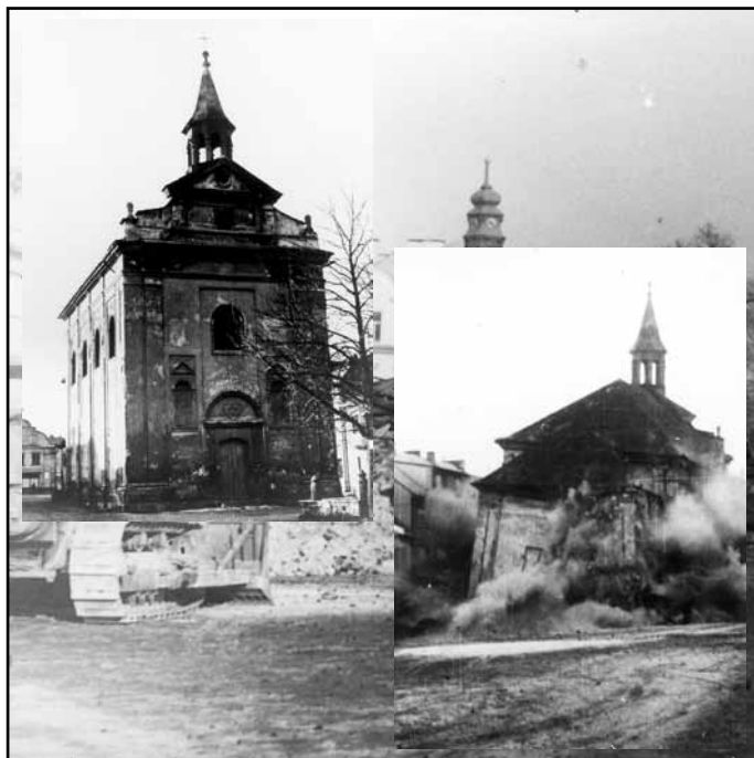
Kostel na náměstí před demolicí a během odstřelu.
