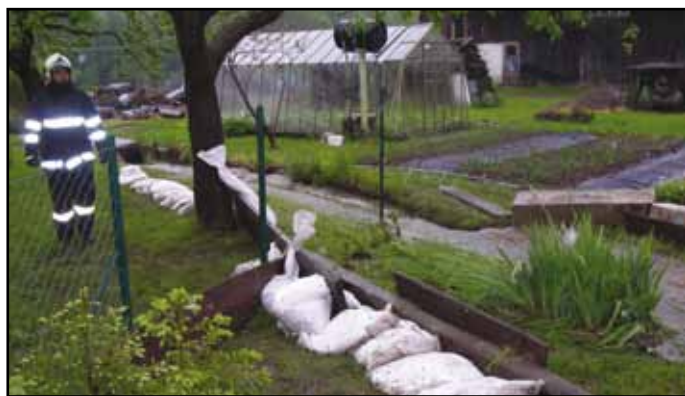
Hráz z pytlů s pískem, kterou postavili hasiči před ohroženým domem.
